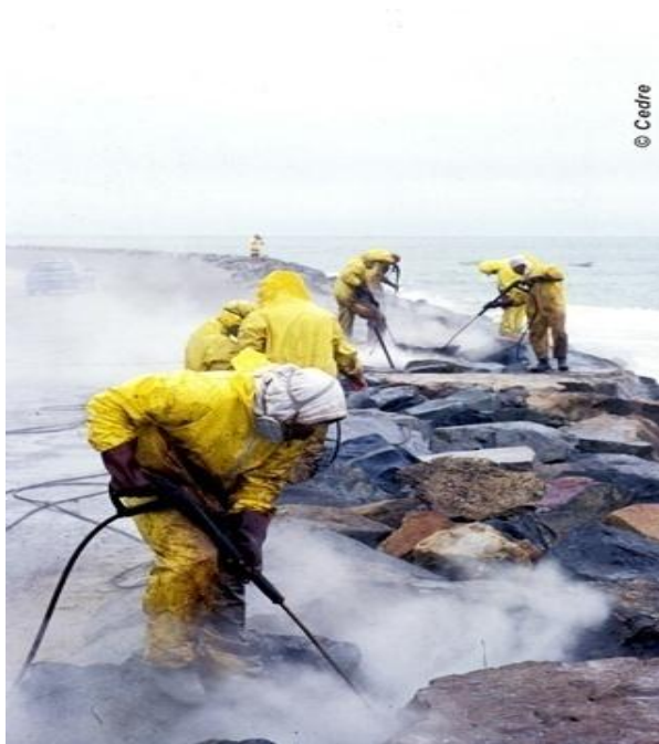
Slika 8.3: Čiščenje naftnih odpadkov z visokotlačnimi čistilniki
