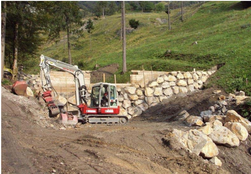
Slika 6.5: Izgradnja vodne pregrade na hudourniku Blatnica
