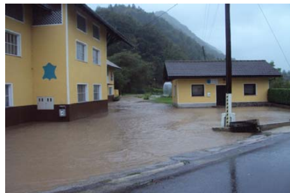
Slika 6.2: Poplavljanje stanovanjskih objektov
