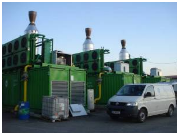
Slika C.5: Kogeneracijski motorji na bioplinarni Lendava
