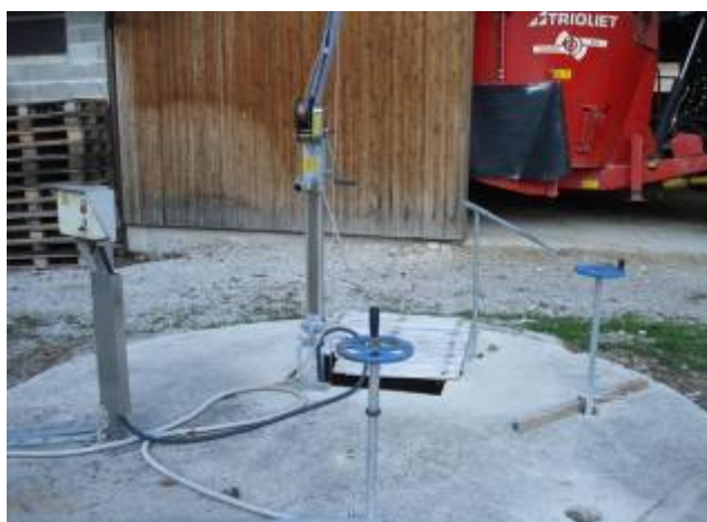
Slika C.1: Zbiralnik vhodnega substrata na bioplinarni Flere
