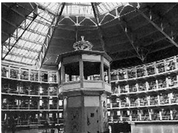
Slika 2.2: Osrednji nadzorni stolp.
