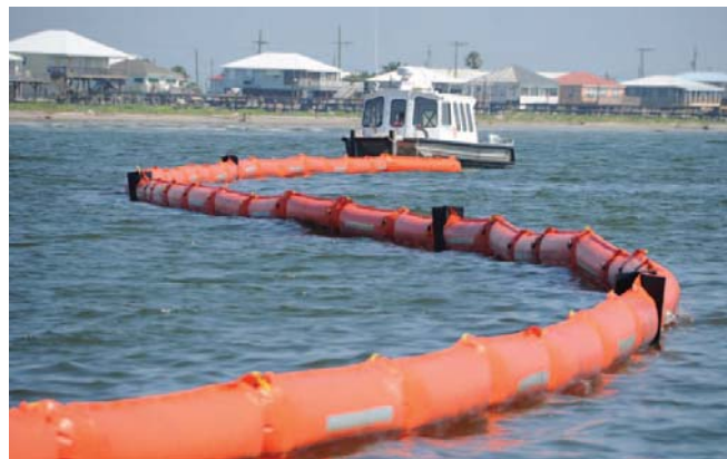
Slika 6.2: Nameščanje vodnih napihljivih pregrad
