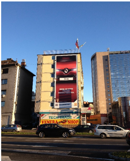
Slika 2.1: Oglasne površine na fasadah
