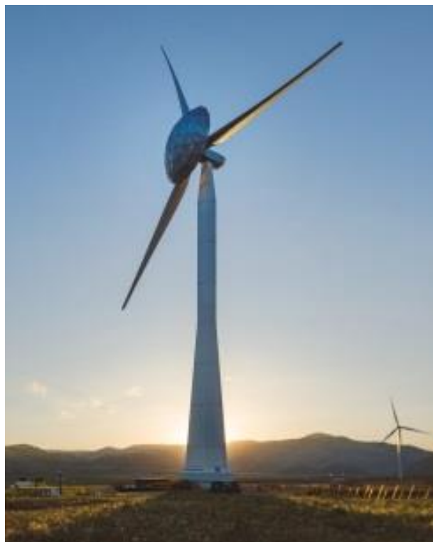
Slika 5.3: Horizontalna vetrna turbina (HAWT) s sredinskim deflektorjem
