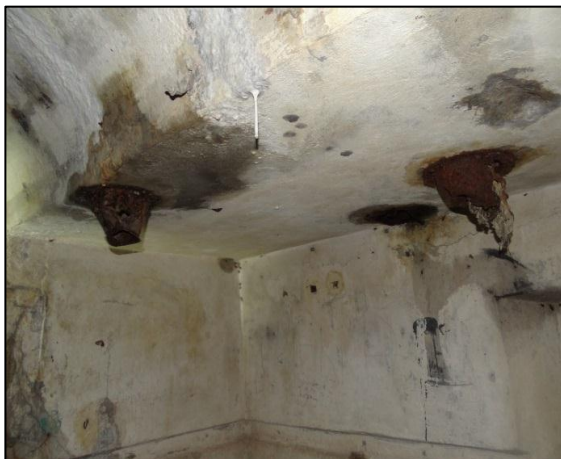
Slika 25. V stropu vidne cevi namenjene prezračevanju prostora (levo)
