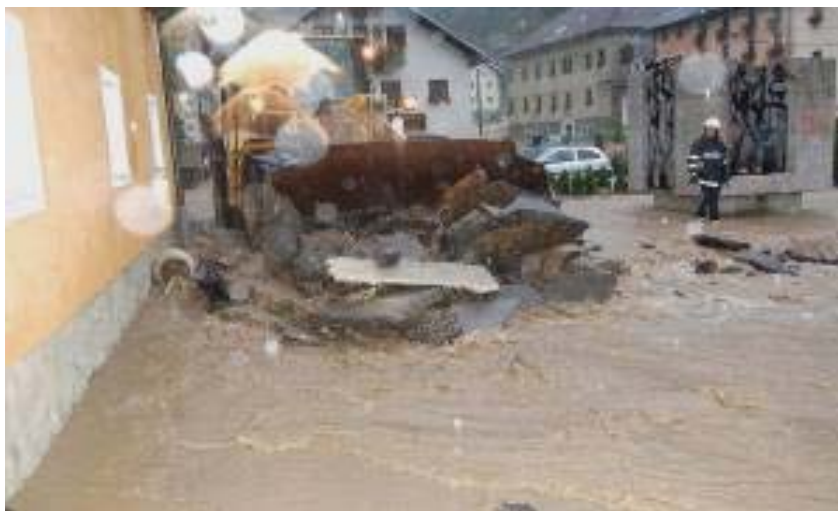
Slika 57: Plac pred sanacijo.
