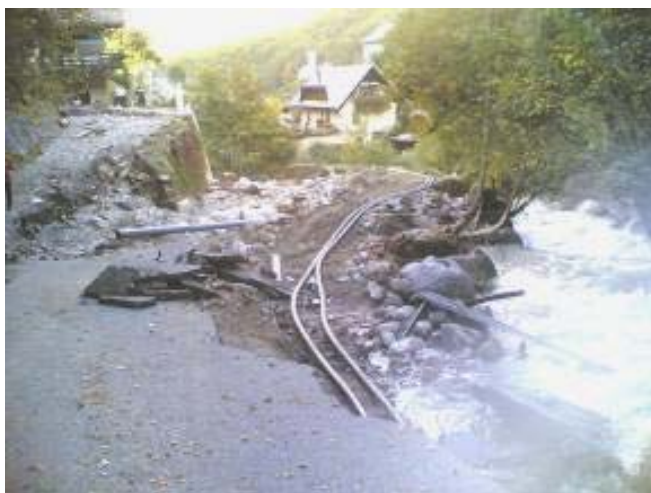
Slika 55: Državna cesta pred obnovo.
