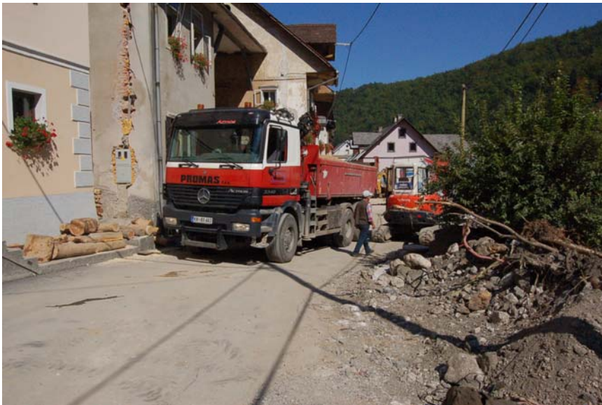
Slika 44: Pomoč gradbene mehanizacije pri odpravljanju posledic ujme.
