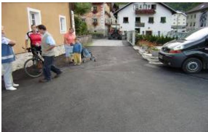
Slika 58: Plac po sanaciji.
