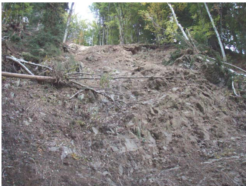
Slika 48: Plaz Črni potok.
