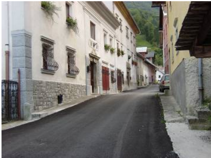
Slika 54: Gosposka ulica po končani sanaciji.
