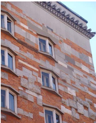
Fotografija 6.4: Okna najvišjih nadstropij na pročelju Narodne in univerzitetne knjižnice
