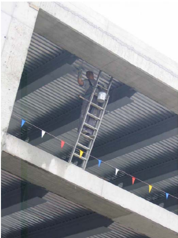
Slika C. 2: Delo brez zaščitnega odra – padec v globino je neizbežen
