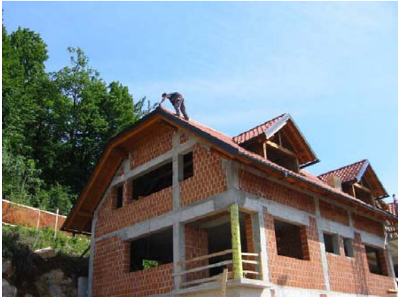
Slika C. 1: Delo na strehi brez zaščite
