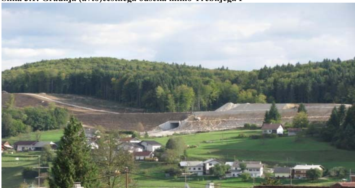
Slika 3.1: Gradnja (avto)cestnega odseka mimo Trebnjega I
