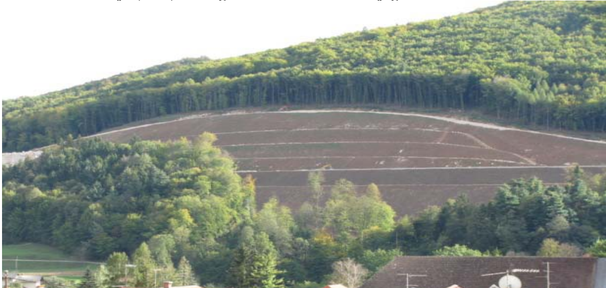
Slika 3.2: Gradnja (avto)cestnega odseka mimo Trebnjega II
