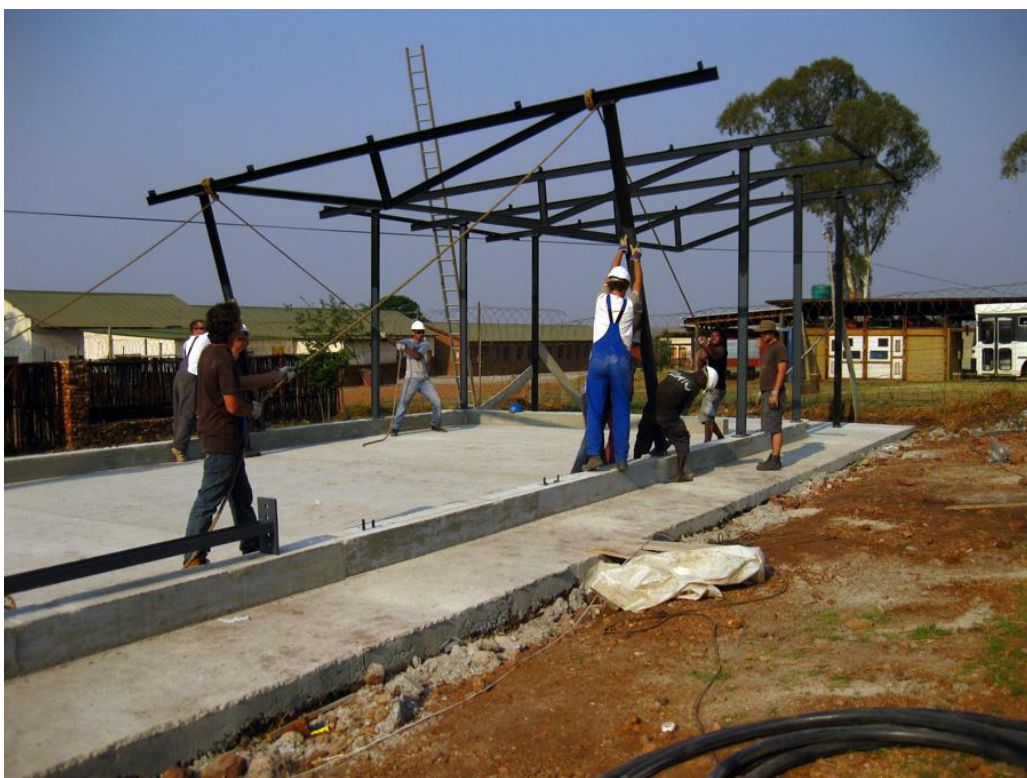
Slika B.2: Postavljanje konstrukcije
