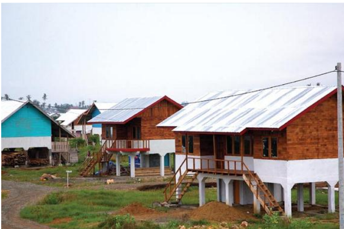
Slika 4.1: Novozgrajene hiše v vasi Lam Isek
