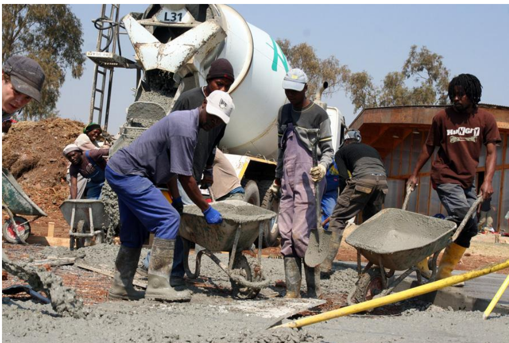
Slika B.1: Betoniranje temeljev
