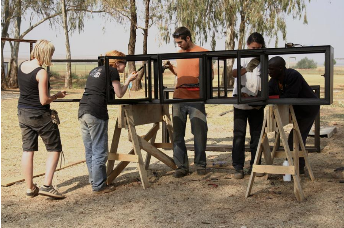
Slika B.3: Barvanje okenskih okvirjev
