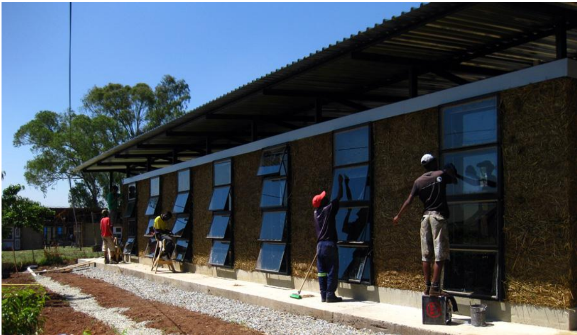
Slika B.4: Vstavljanje stekel v okna
