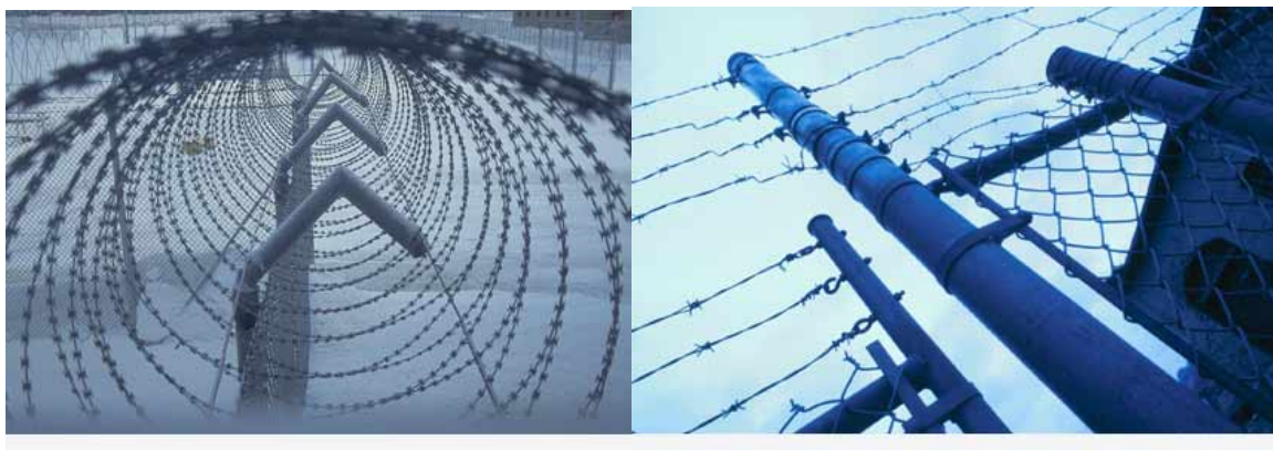
Slika 5.6: Varovalna ograja zavoda za prestajanje kazni zapora Dob pri Mirni
