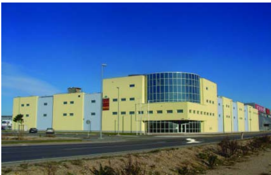
Slika 5.2: Zavod za prestajanje kazni zapora Koper
