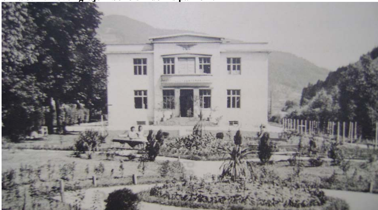
Slika 5.12: Novo zgrajeni Sokolski dom s parkom.
