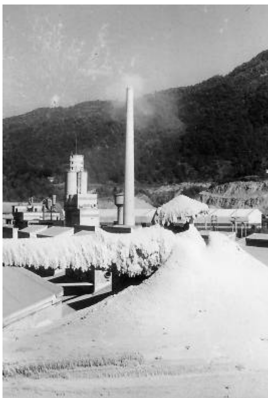
Slika 3.2.1.1.3.3.1.1: Pogled s strehe hale za pripravo azbesta na staro cementarno. Fotografija ni posnetek snežne idile, ampak so vidni sloji azbesta. Vir: Društvo OZA
