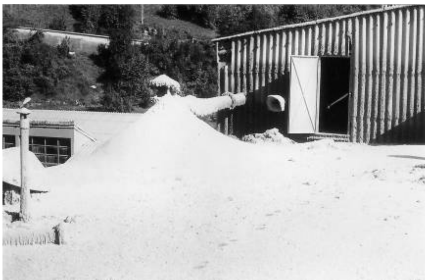
Slika 3.2.1.1.3.3.1.3: Posnetek strehe na hali priprave azbesta – izstop odpraševalne cevi iz filtra za odpraševanje proizvodne hale. Vir: Društvo OZA
