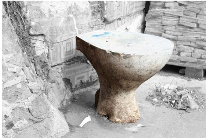
Slika 4.14: Zabetonirana straniščna školjka
