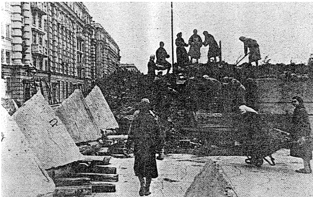
SLIKA 1: Izgradnja obrambnih položajev v mestu
