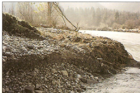
Savinja nad Sotesko, poškodba avstro-ogrske regulacije
