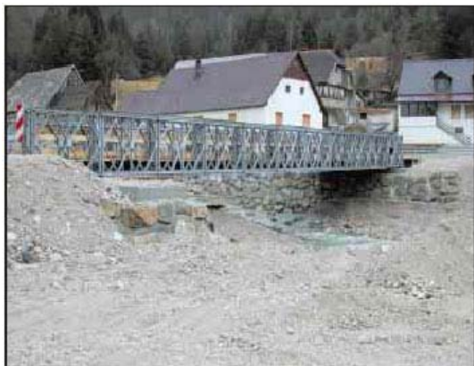
Slika 7: Nadomestni montažni most čez Predelico v Zgornjem Logu
