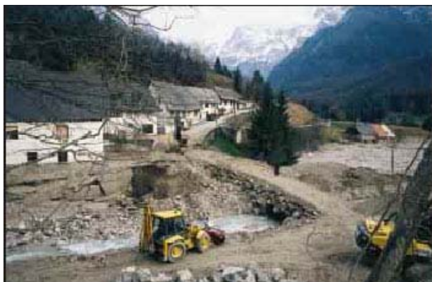
Slika 9: Zasilni most čez Predelico v Zgornjem Logu
