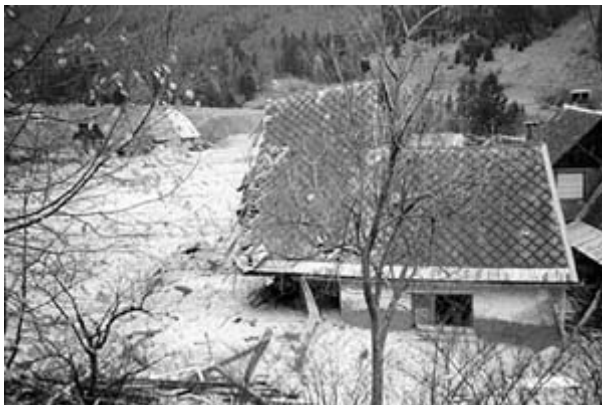
Slika 6: Posledice plazu na objektu v Zgornjem Logu
