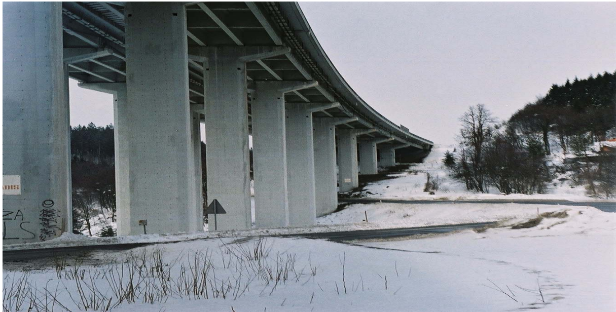
Slika 22: Viadukt Ravbarkomanda – primeren kraj za oviranje prometa (Foto: Blaž Jenko, 9.3.2004)
